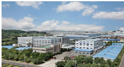
Siwha production site
